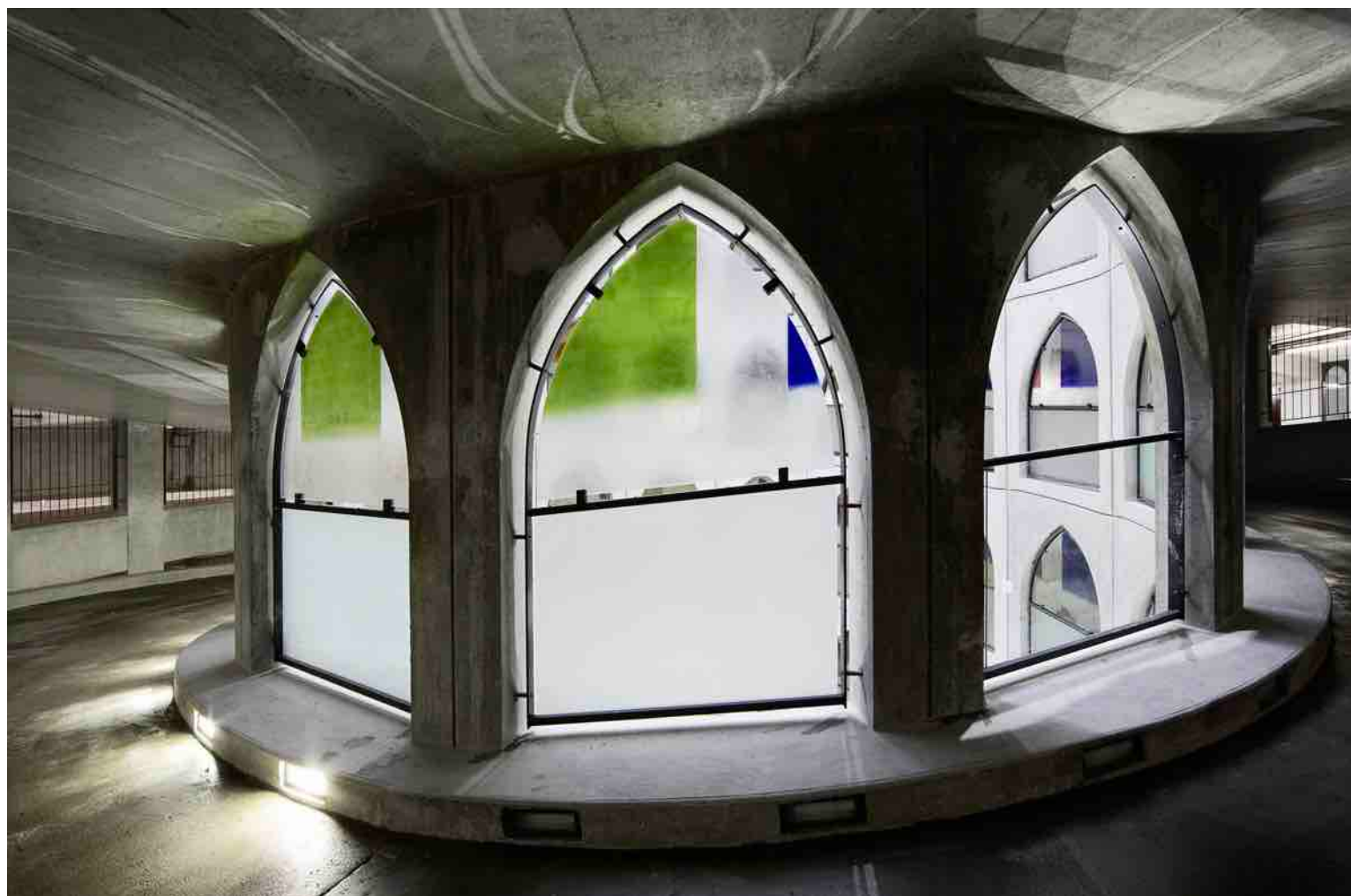
Verrières de l'est au nord, étage -3.
