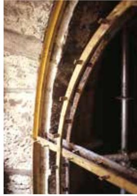
*Les cadres métalliques ont été remplacés par des cadres en laiton haute résistance. Ce matériau ne se dilate pas, il est moins lourd et plus résistant que le fer. Il ne s'oxyde pas et peut se patiner.*
