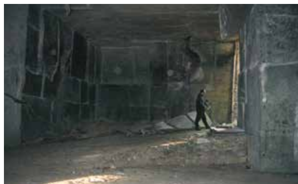
Fongrenon, entrée ouest de la carrière avec rampe d'accès pour camion.
