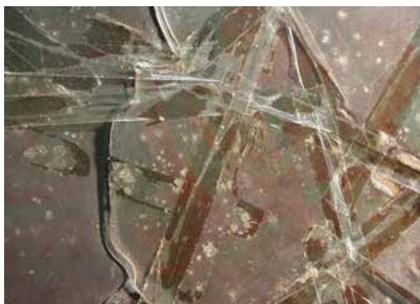
Surfaces peintes contaminées par des champignons, et dégradées par la pose d'adhésifs lors d'une ancienne consolidation. Château de La Bâtie d'Urfé.
