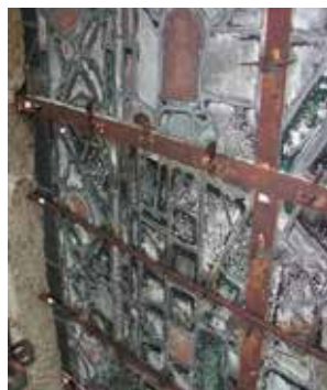
Corrosion des verres en face externe. Baie 101, cathédrale Notre-Dame de Chartres.
