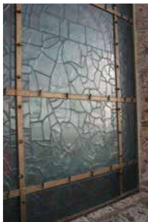
Doublage de protection par verre thermoformé à l’empreinte du verre ancien. Cathédrale Notre-Dame de Chartres.
