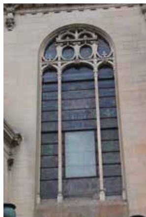
Doublages des vitraux par simple fenêtre. Château de Chantilly, galerie de Psyché.
