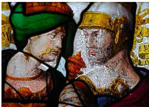
Corrosion des verres en face interne, vue en transparence. Vitrail de l'église de l'Immaculée Conception de Montaudin (Mayenne).
