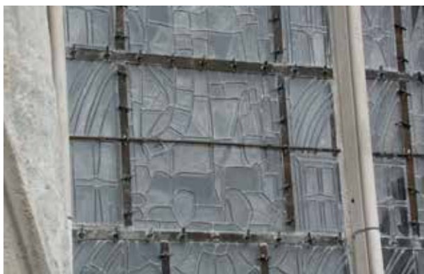
Doublage par mise en plomb de verre transparent à la forme du vitrail ancien.
