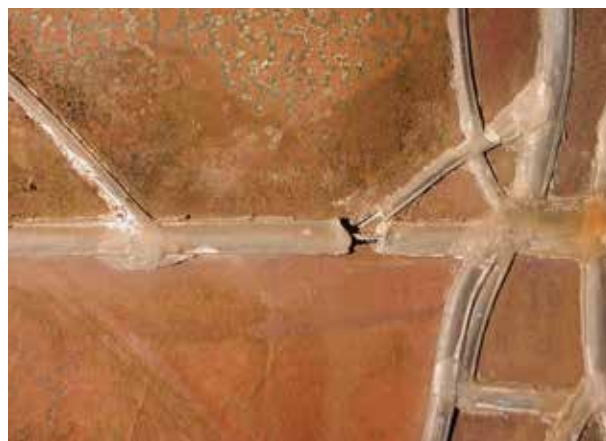
Rupture de plomb. Vitrail de l'église de l'Immaculée Conception de Montaudin (Mayenne).
