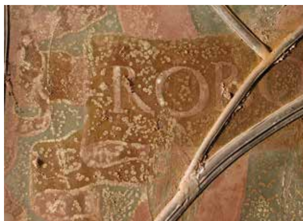
Corrosion des verres en face interne. Vitrail de l'église de l'Immaculée Conception de Montaudin (Mayenne).
