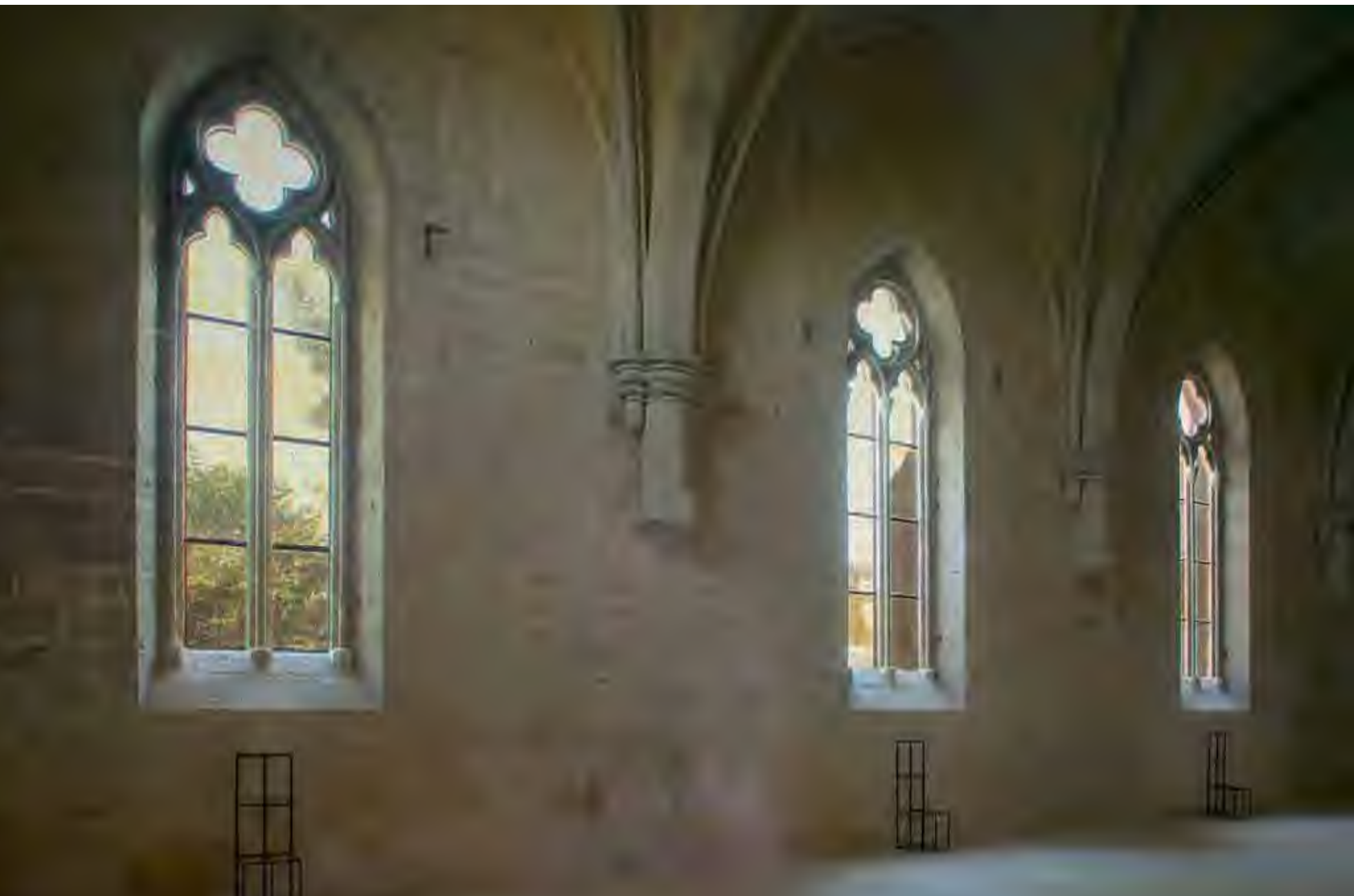
Baies du réfectoire, mur méridional
