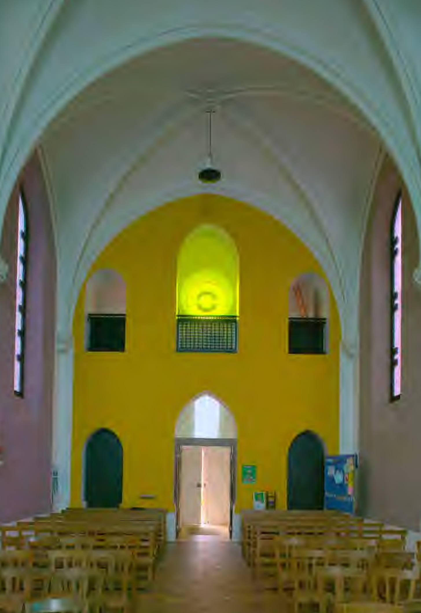
Façade occidentale, vue intérieure
