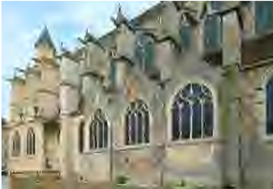
Église Saint-Étienne, façade méridionale
