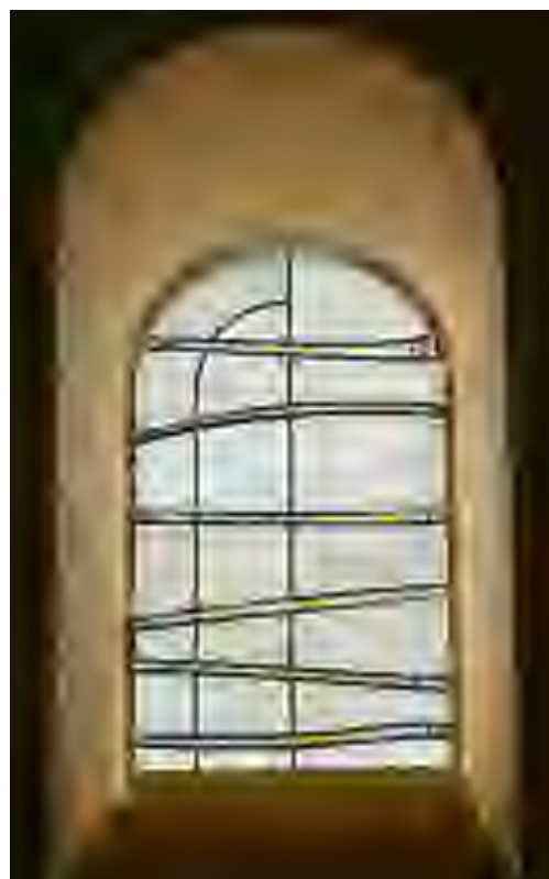
Façade occidentale, baie n°19
