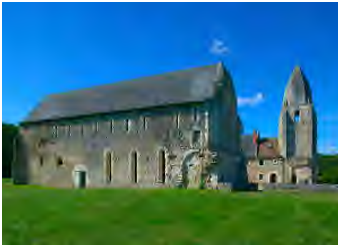
Prieuré Saint-Jean-du-Grais. Bâtiment des moines, salle capitulaire, à l'étage, dortoir.
